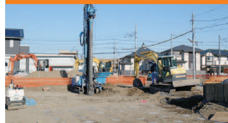
[施工場所] 千葉県 [施工数量] 4m×750本
