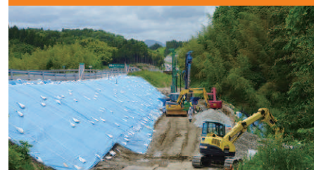
[施工場所] 宮城県 [施工数量] 5m×200本
