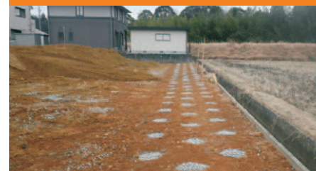
[施工場所] 三重県 [施工数量] 1.75m×156本
