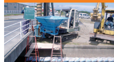
[施工場所] 三重県 [施工数量] 3~3.5m×20本
