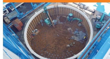
[施工場所] 埼玉県 [施工数量] 4.76m×292本
