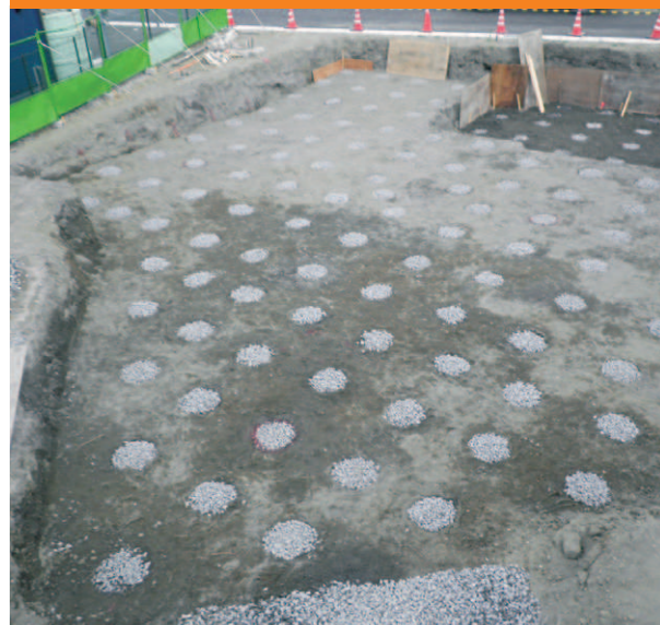
[施工場所] 千葉県 [施工数量] 4.5m×171本
