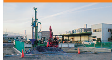
[施工場所] 三重県 [施工数量] 2.25m×51本
